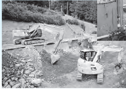
旧水処理施設解体作業
