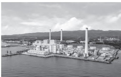
(株)JERA広野火力発電所
