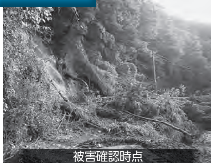
被害確認時点
