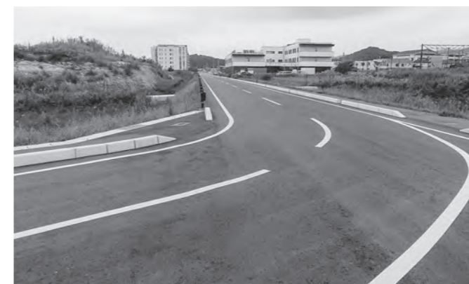
完了した道路整備事業
