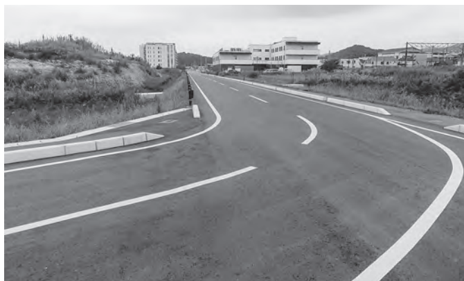
完了した道路整備事業
