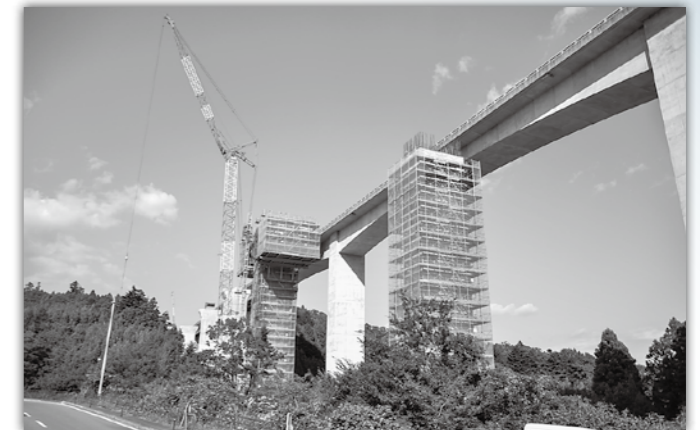
常磐自動車道4車線化(いわき中央インターから広野インター間)事業(上北迫地内の工事の様子)9月25日撮影
