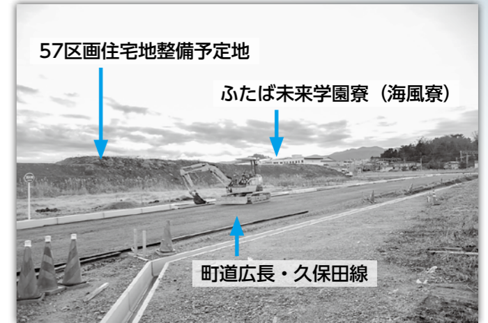
住宅整備予定地と町道広長・久保田線道路新設舗装工事の様子
