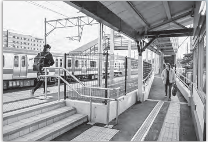
完成したJR広野駅ホームのバリアフリー化
