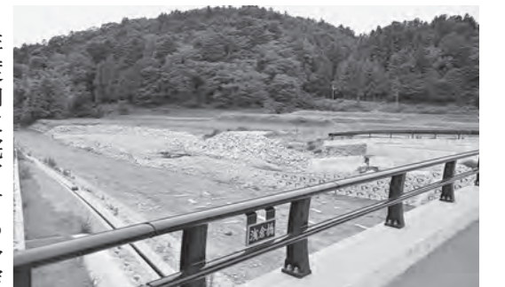
準備工事が完了した浅倉橋周辺
