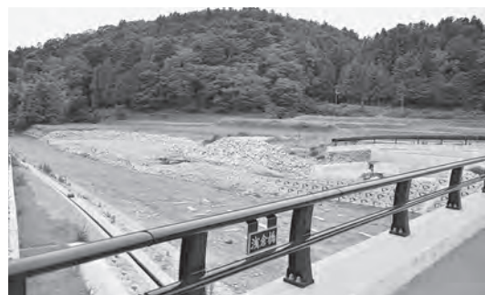
準備工事が完了した浅倉橋周辺
