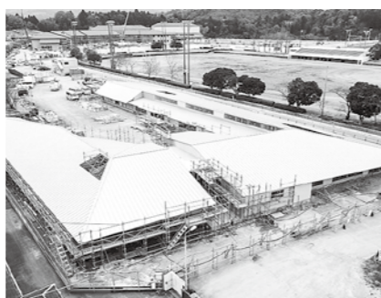
開園に向け進む工事
