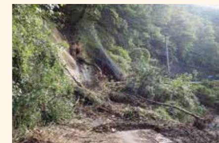
県道上戸渡・広野線の路肩崩落（上浅見川字鈴平地内）
