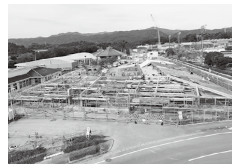
開園に向け進む工事（認定こども園）
