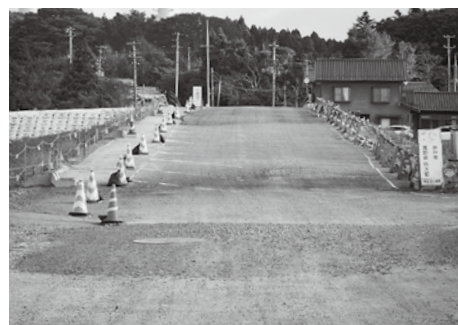
町道築地・新町線の舗装工事を実施
