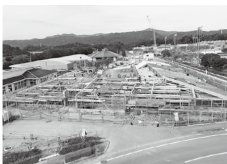
開園に向け進む工事（認定こども園）
