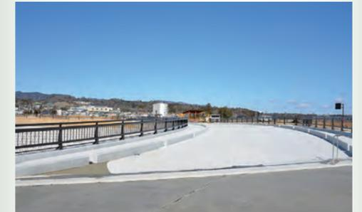
日の出橋は、県道広野小高線と町内折木地区を結ぶため、浅見川河口に新設されている橋で、長さ49.4メートルのコンクリート製です。今月中の完成を目指して建設が進められています。
