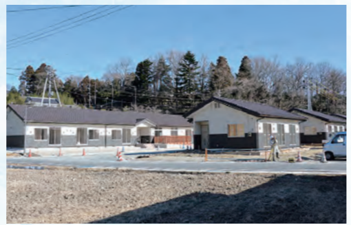
建物の工事がほぼ終了した第2期災害公営住宅
