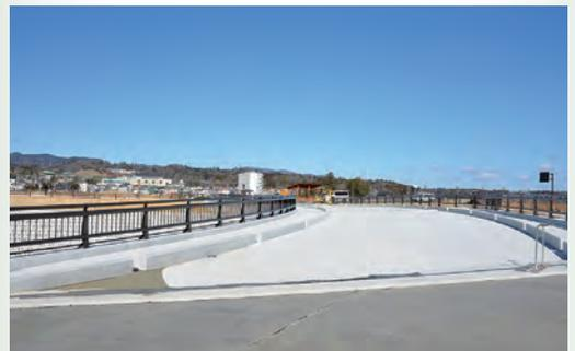
日の出橋は、県道広野小高線と町内折木地区を結ぶため、浅見川河口に新設されている橋で、長さ49.4メートルのコンクリート製です。今月中の完成を目指して建設が進められています。
