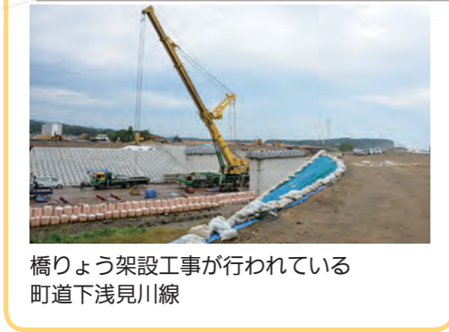
橋りょう架設工事が行われている町道下浅見川線
