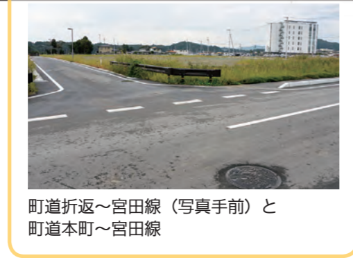
町道折返～宮田線（写真手前）と町道本町～宮田線
