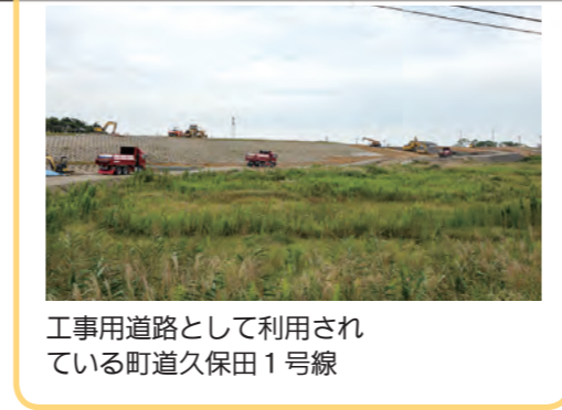
工事用道路として利用されている町道久保田1号線
