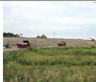
工事用道路として利用されている町道久保田1号線
