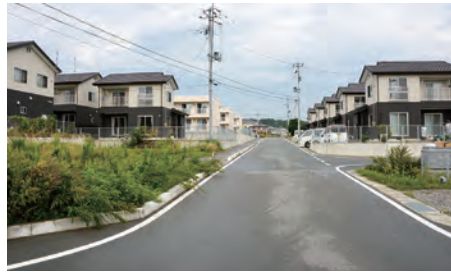
町道広長～川原田線と災害公営住宅（第1期）
