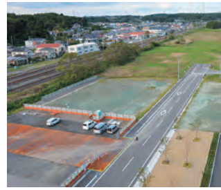
町道広長～久保田線と第2期整備エリア（写真奥）
