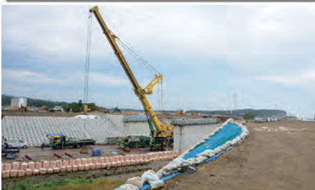
橋りょう架設工事が行われている町道下浅見川線
