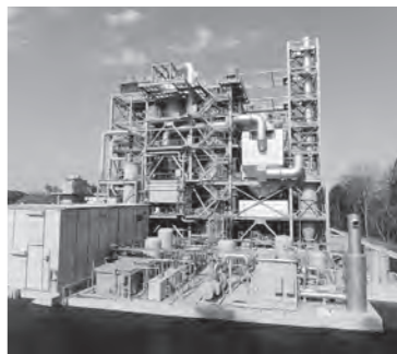
仮設減容化施設全景
