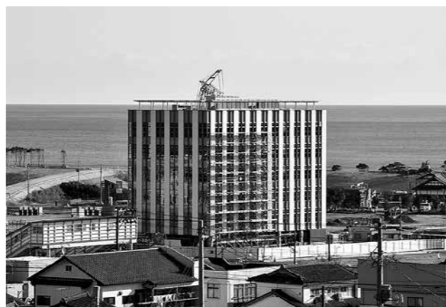
↑ 建設中の広野みらいオフィス
