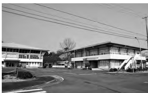
改修が完了した中央体育館と公民館
