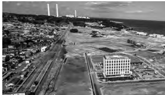
広野みらいオフィスが完成するなど広野駅東側開発整備事業が進む
