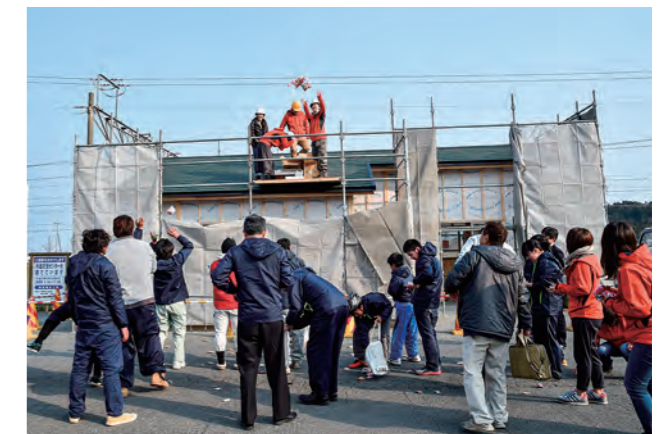
↑木造交流センター上棟式の様子
