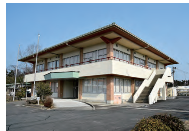
↑改修工事が完了した公民館
