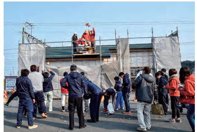
↑木造交流センター上棟の様子
