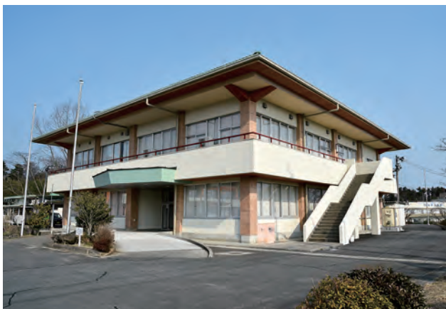
↑改修工事が完了した公民館
