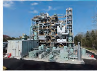
仮設減容化施設全景
