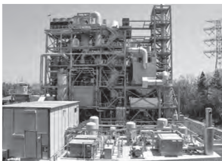
災害廃棄物等仮設減容化処理施設
