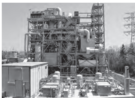
災害廃棄物等仮設減容化処理施設
