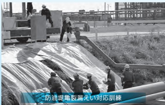
防油堤亀裂漏えい対応訓練
