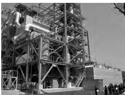
災害廃棄物等仮設減容化処理施設
