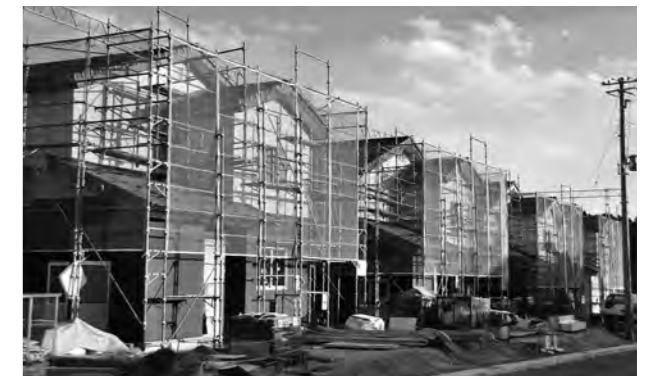
↓災害公営住宅建設現場の様子
