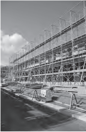
災害公営住宅建設現場の様子
