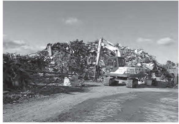
町内にある仮置き場
