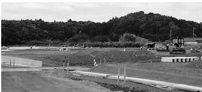
↑災害公営住宅建設予定地
