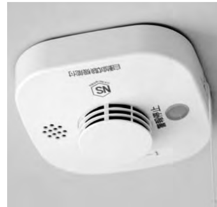
平成23年5月31日までに設置することが義務づけられている住宅用火災報知器
