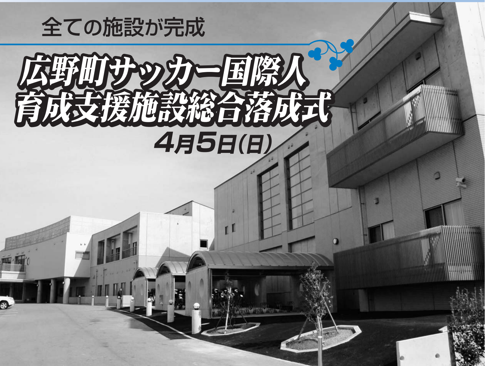
広野町サッカー支援センター
