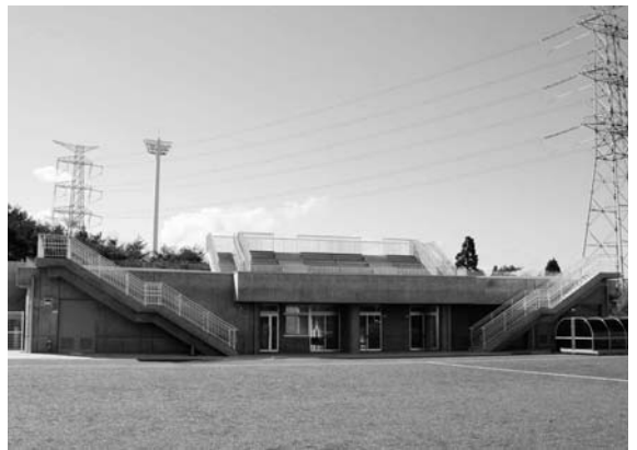
広野町サッカー場クラブハウス
