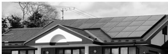
太陽光発電システムを設置している住宅
