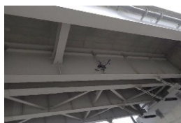
ドローンによる桁下の点検
