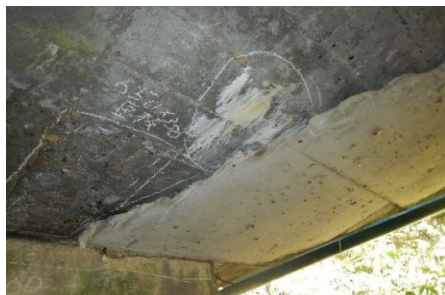
35. 第三南沢橋：RC床版橋 (橋長：4.50m、1975年竣功) 床版下面の錆汁を伴う遊離石灰の析出 ※雨水の浸入により、内部鋼材の腐食が進行する可能性が高い。(迂回路有り)
