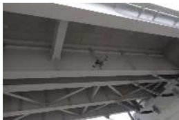
ドローンによる桁下の点検
