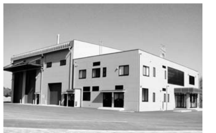
広域圏汚泥リサイクルセンター (大熊町)
