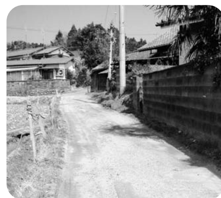
未整備の生活道路
