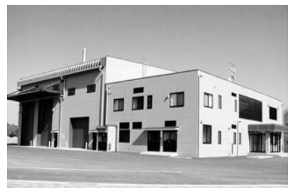
広域圏汚泥リサイクルセンター (大熊町)
