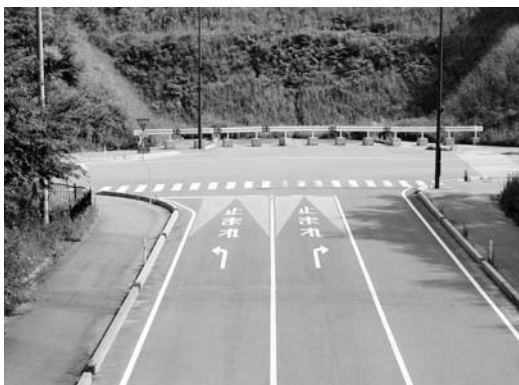
延長工事が待たれる県道広野く小高線（東電入口付近）
