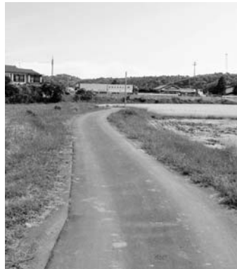
現道舗装工事が施された切通農道
