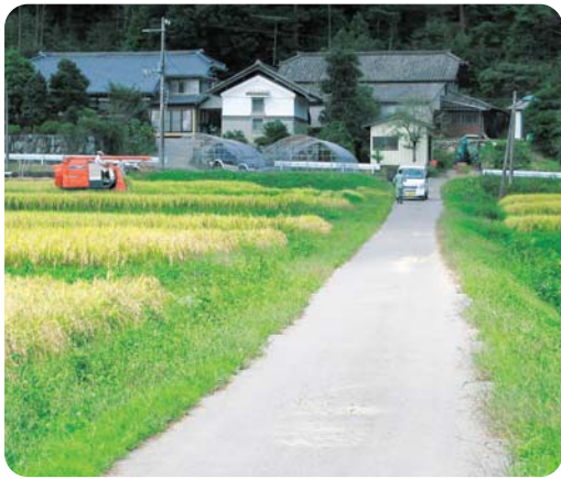
現道舗装された農道（上原地区）
