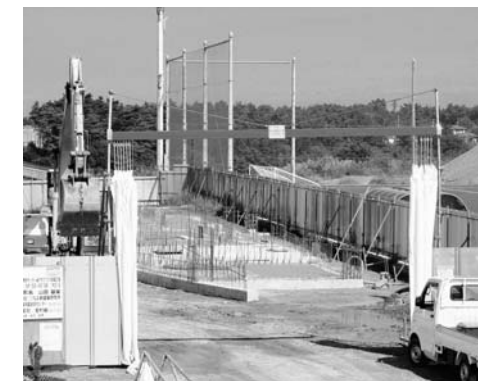
広島町サッカー場クラブハウス工事現場
