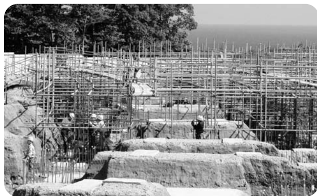
建設が始まった男子寄宿舎新築工事
