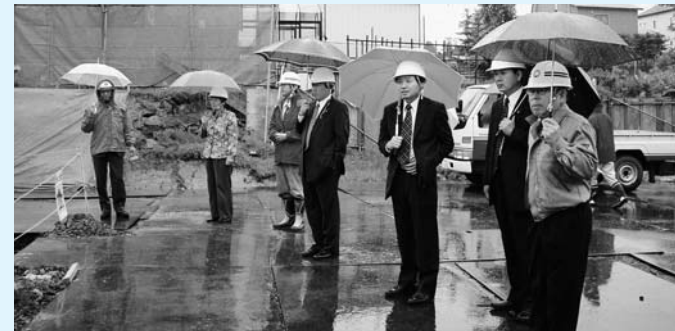
ニセコ町幼保総合施設の建設現場を視察
