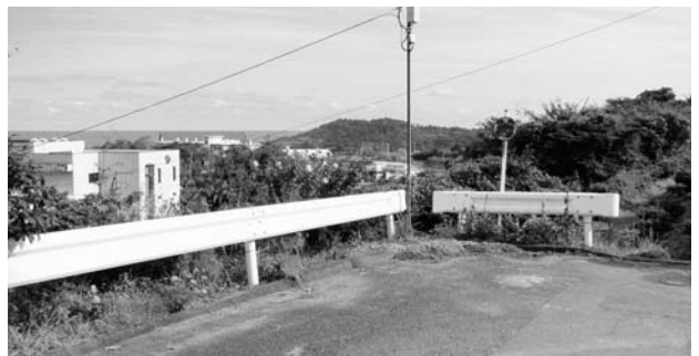
行き止まり状態の生活道路 (苗代替地区)
