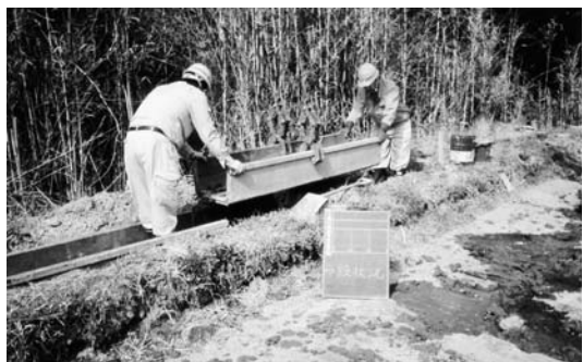
古いU字溝を再利用（随意契約工事）
