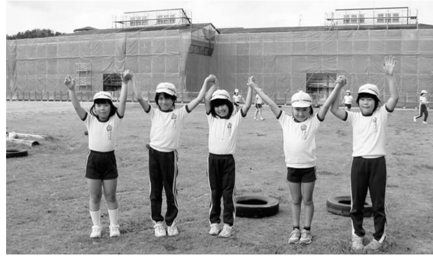
およそ1億円の予算をかけて大規模改修工事が行われている小学校
