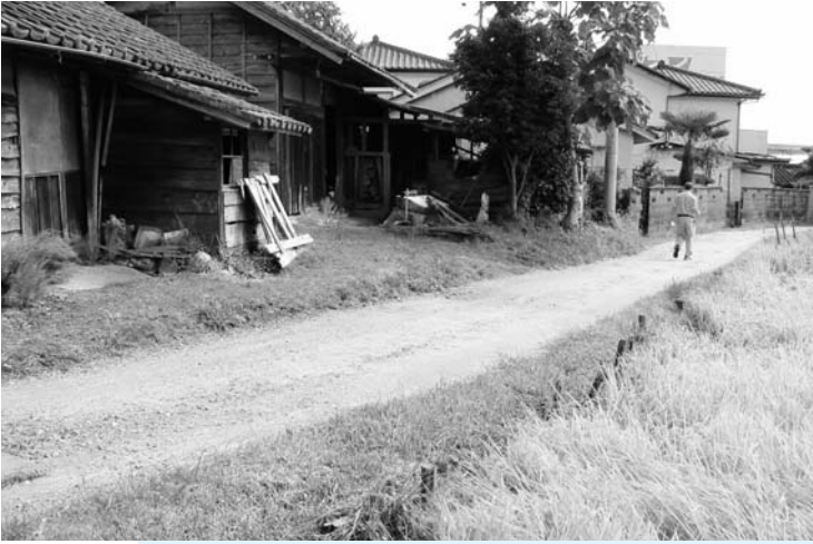
現道舗装工事費が予算化された町道折返線
