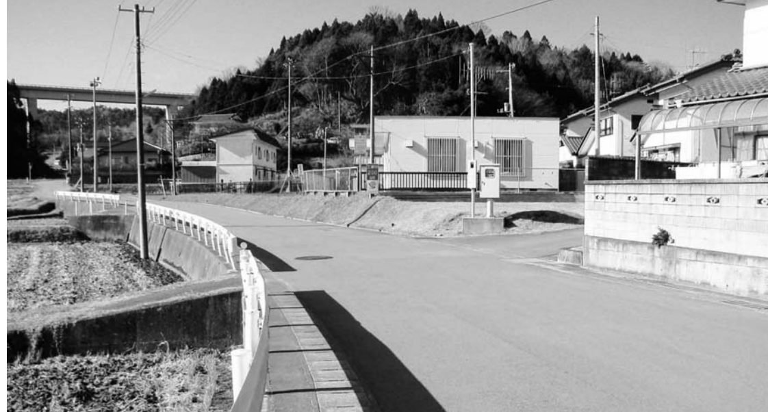
工事が待たれる町道中央台～山ノ神線の未整備区間（上浅見川・虻木）
