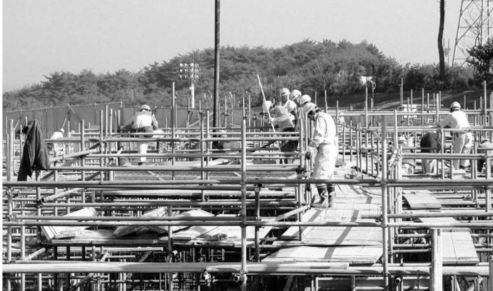
工事が進む男子寄宿舎建築現場
