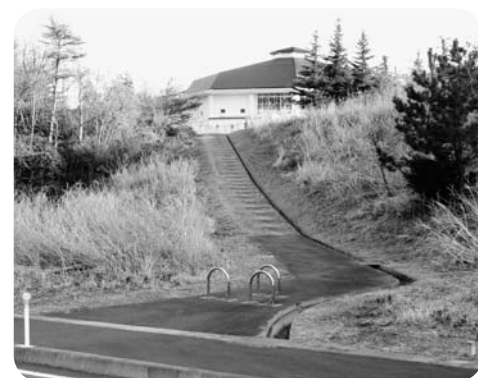
ふるさと農道から小学校北側へと続く歩道
