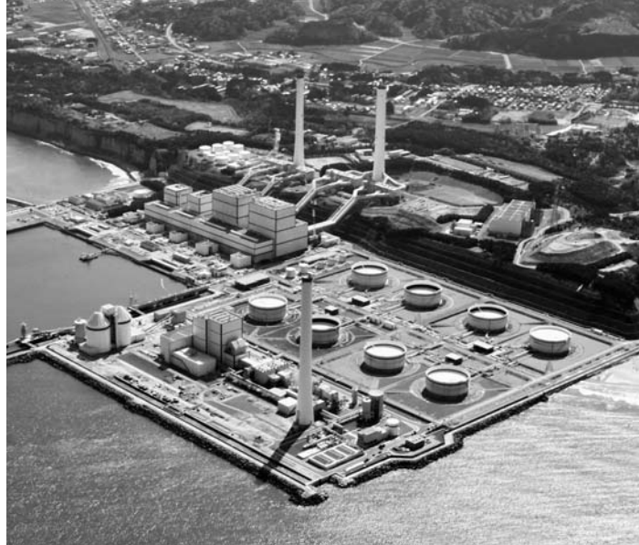
6号機運転開始が平成26年度まで延期された広野火力発電所
