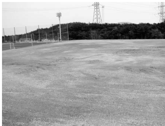
敷地造成工事が完了した雨天練習場予定地
