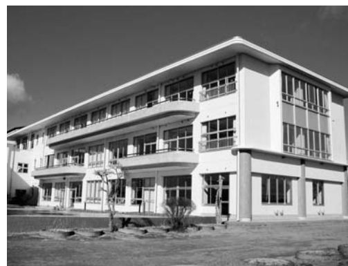
補修工事が完了した小学校校舎
