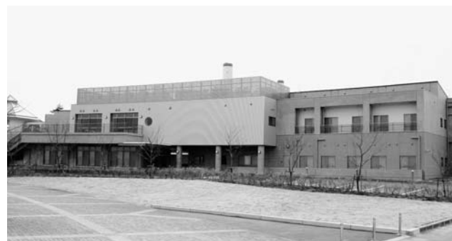
第1期工事が完了した男子寄宿舎（広野町サッカー支援センター）
