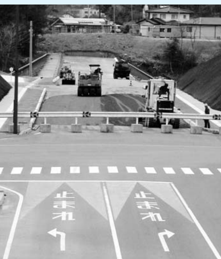
少しずつ工事が進む県道広野〜小高線（下北迫字二ツ沼）
