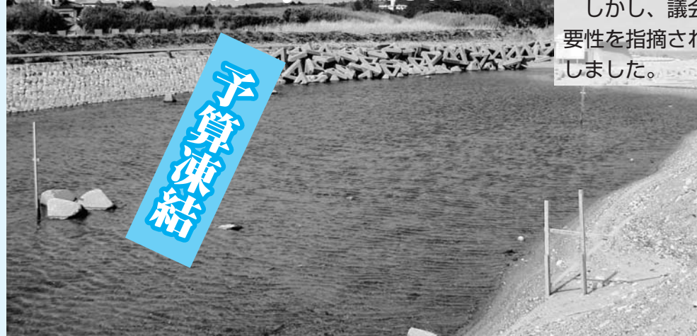
事業費が凍結された「日の出橋」整備予定地（浅見川河口付近）
